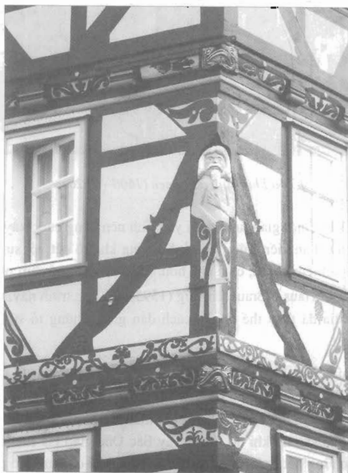
Chi tiết trang trí góc nhà và gờ phân tầng nhà ở cấu trúc gỗ dân gian Đức
