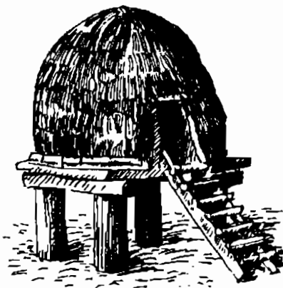
Nhà chòi trên cọc: có tác dụng ngăn thú dữ lên sàn và được làm thành cụm ven sông, hồ. Loại nhà này thấy nhiều ở Thụy Sĩ, Mông Cổ.
